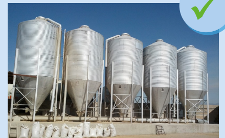
Silos en bon état
