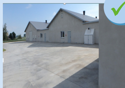
Zone environnante bétonnée
