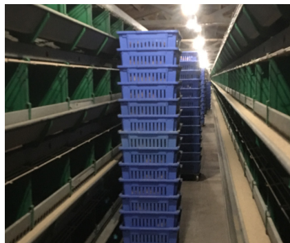
Caisses réparties dans le bâtiment
