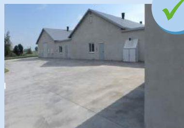
Забетонированная окружающая зона
