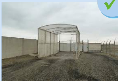
Túnel de desinfección para vehículos
