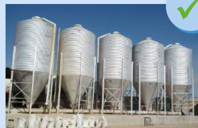
Silos en buenas condiciones
