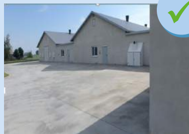
Zona de cemento en los alrededores
