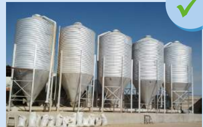
Силосы в хорошем состоянии
