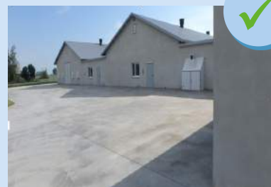
Забетонированная окружающая зона
