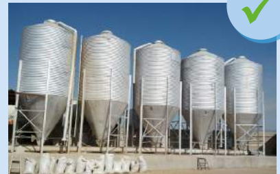
Silos en bon état
